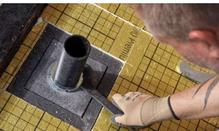
5. Leichtes Versenken der Spannmutter in die jeweilige Dämmstärke.
