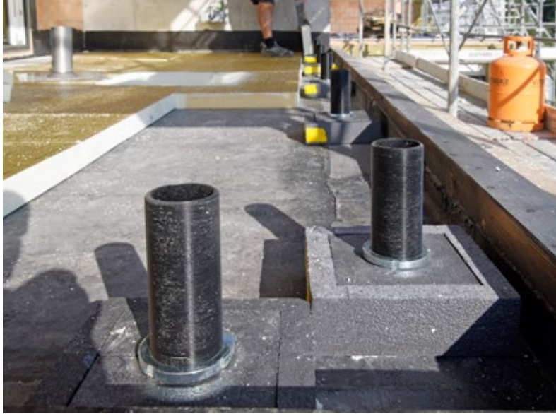
3. Zeitsparend und verarbeiterfreundlich kann mittels Dämmwürfel eine saubere Wärmedämmebene erstellt werden.
