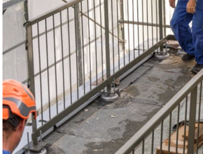
11. Einbau des Staketengeländers auf das BefTec DRY.SYSTEM
