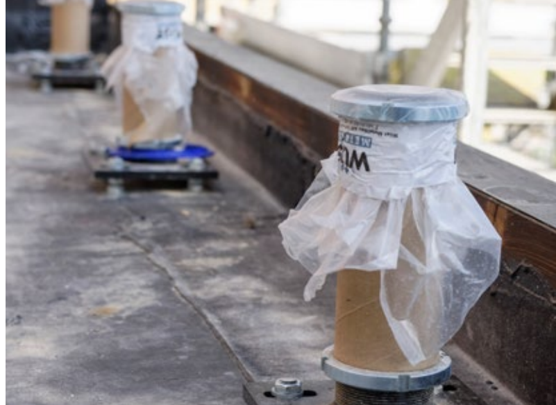
2. Ausrichtung der BefTec UK II-B. Mittels Langlöcher in der Unterkonstruktion kann die UK genau auf die gewünschte Flucht ausgerichtet werden.
