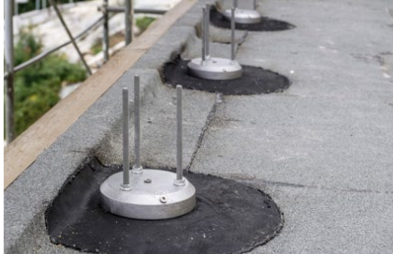
10. Einbau der 2. Lage und dem DS180.
