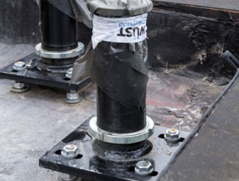
1. Montage der UK II-B 55-200 mm auf den Untergrund mit einer Aufständigung von ca. 2 cm.
