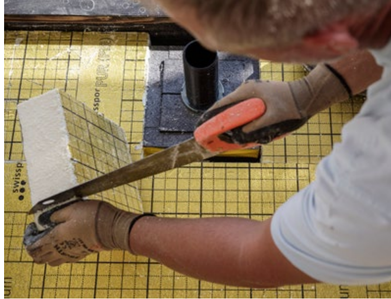
4. Einbau der Flächendämmung PIR Premium und Ausschnitt an den Dämmwürfel.
