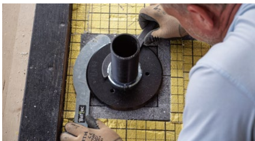
6. Befestigen und Ausrichten der Ronde (Durchmesser 205 mm) mit BefTec-Spezialwerkzeug.
