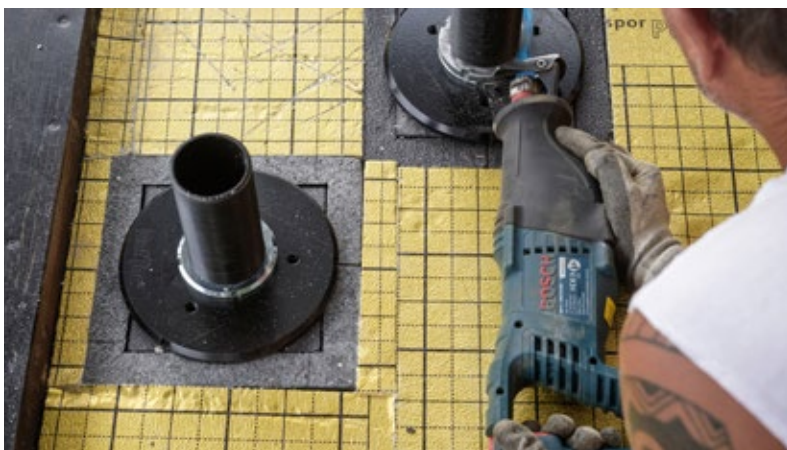
7. Kürzen der UK II-B auf die gewünschte Dämmstärke.
