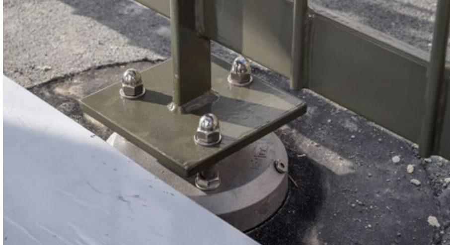
12. Aufnahme des Staketengeländers über die drei Gewindestangen des DS180.
