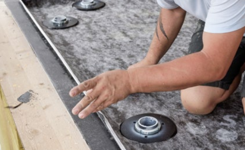
9. Verlegen der ersten Lage.
